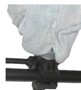
4. Coloque o capuz na ponta do condutor derivado, tomando cuidado ao inseri-lo pois força excessiva pode danificar sua isolamento.
