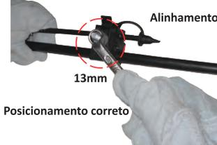
6. Dê o torque com a chave até romper a cabeça fusível do parafuso. O rompimento indicará que o conector está devidamente instalado.
